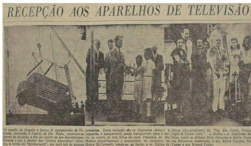
Fig. 03: Chegada a Santos do equipamento da televisão. “Recepção aos aparelhos de televisão” (DSP, 05/02/1950)
